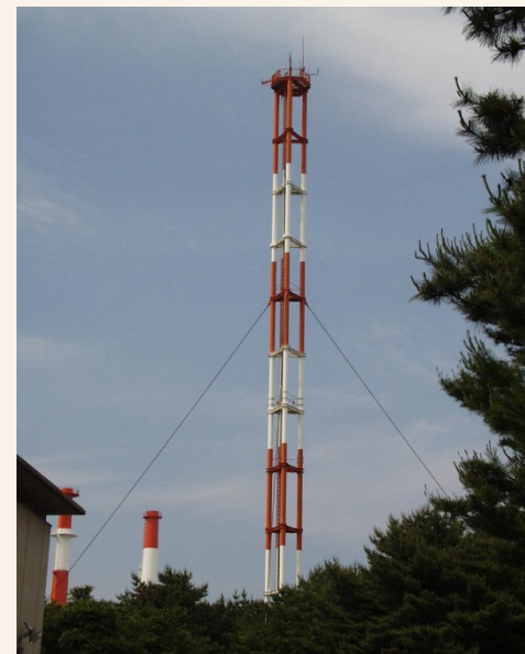
写真1-2. 気象観測塔全景
